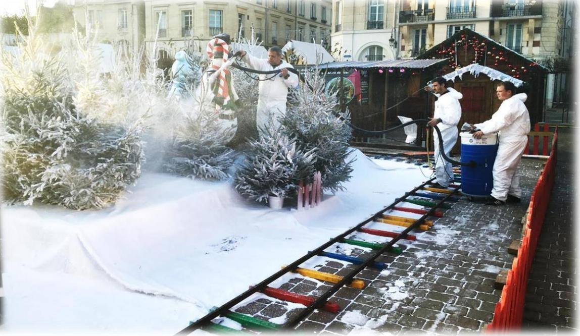
**Système performant à base de cellulose et d'eau, permettant un enneigement très réaliste et durable.**
